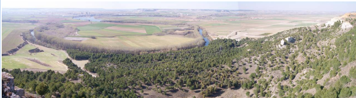
F.42.1.- Vista del meandro del Pisuerga y el deslizamiento generado en su parte cóncava oriental (área repoblada con pinos). Vista hacia el noroeste.
