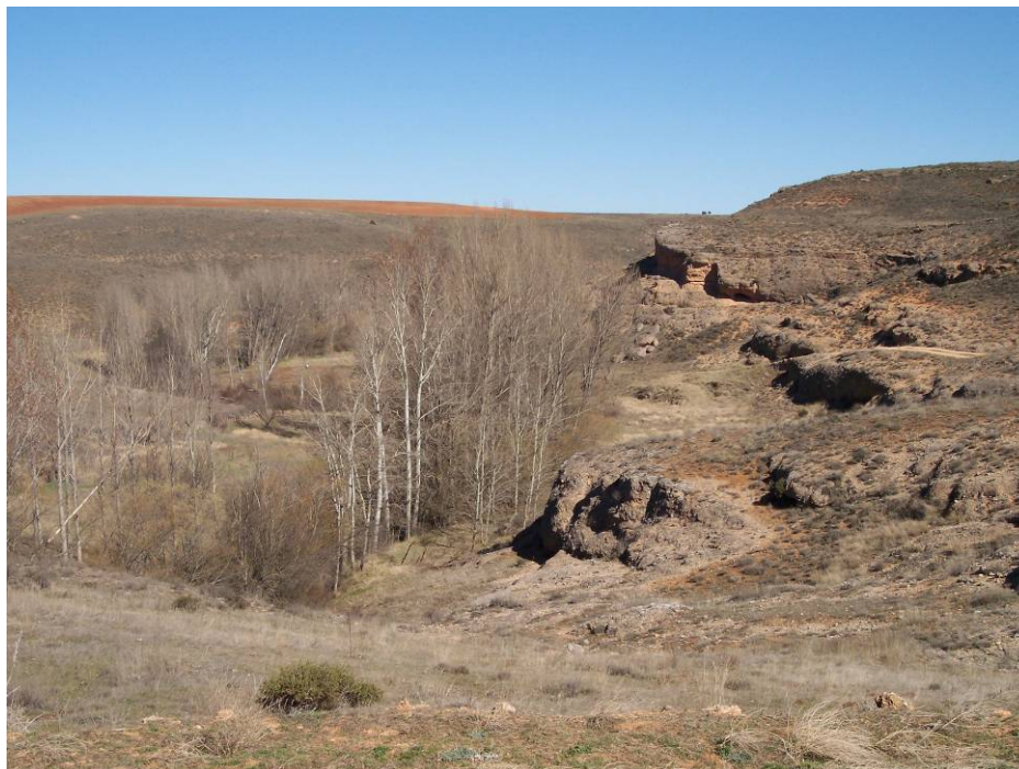
F.51.1.- El río Talegones en la parte alta (o inicial) del tramo propuesto, inmediatamente al norte de la carretera SO-132 (Lumías-Arenillas). Vista hacia el norte. Trazado algo meandriforme y cantiles tallados en conglomerados terciarios.
