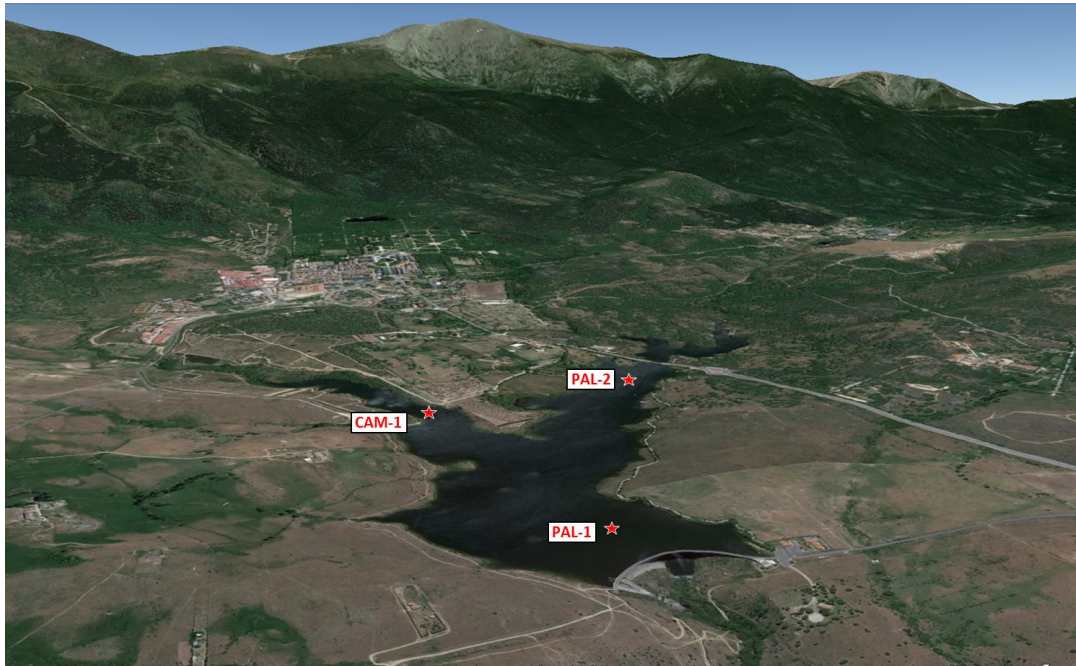
Figura 2. Vista aérea del embalse de Pontón Alto y su cuenca.
