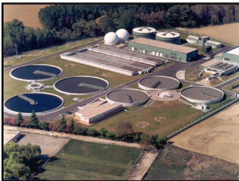
EDAR de la ciudad de Palencia. Autor: Área de Calidad de las Aguas de la CHD.
