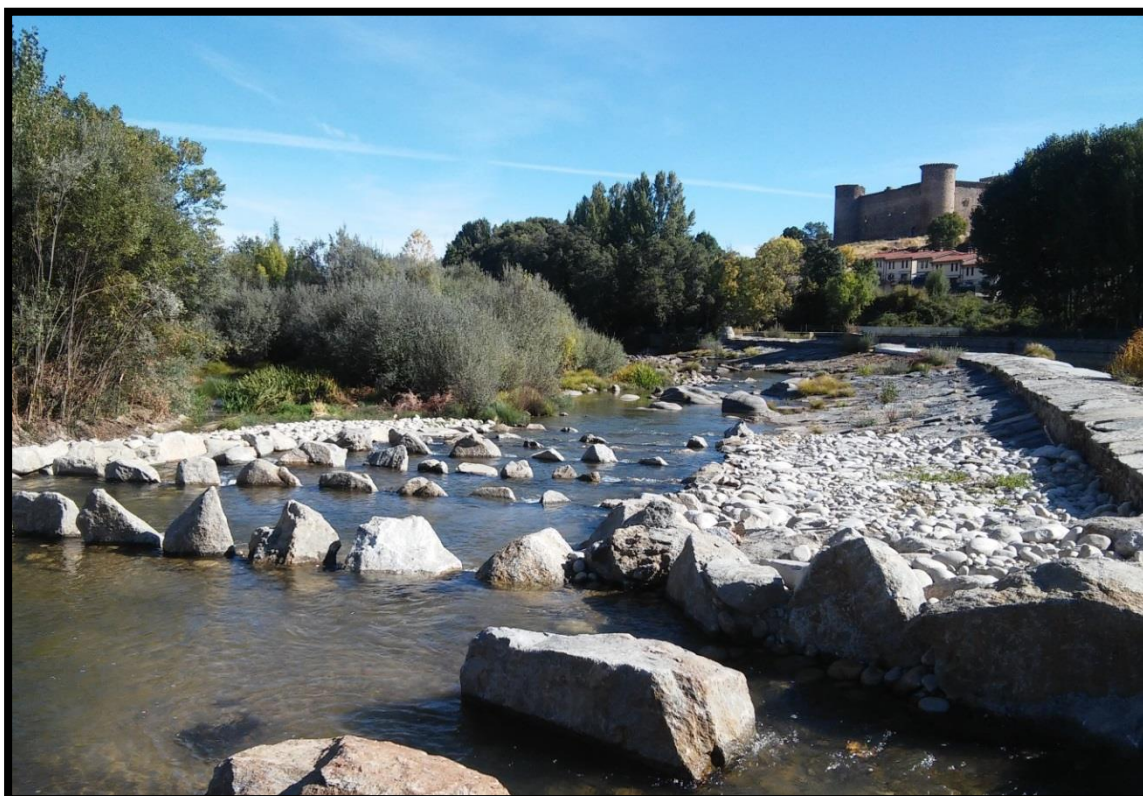
Rampa para peces en azud sobre el río Tormes en El Barco de Ávila (Ávila). Autora: Verónica Orozco Valiente.
