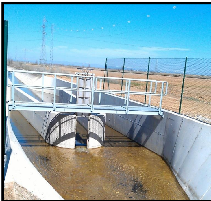
Toma del Canal de Matalobos, Canal del Páramo (León). Autor: José Reguera Acevedo.
