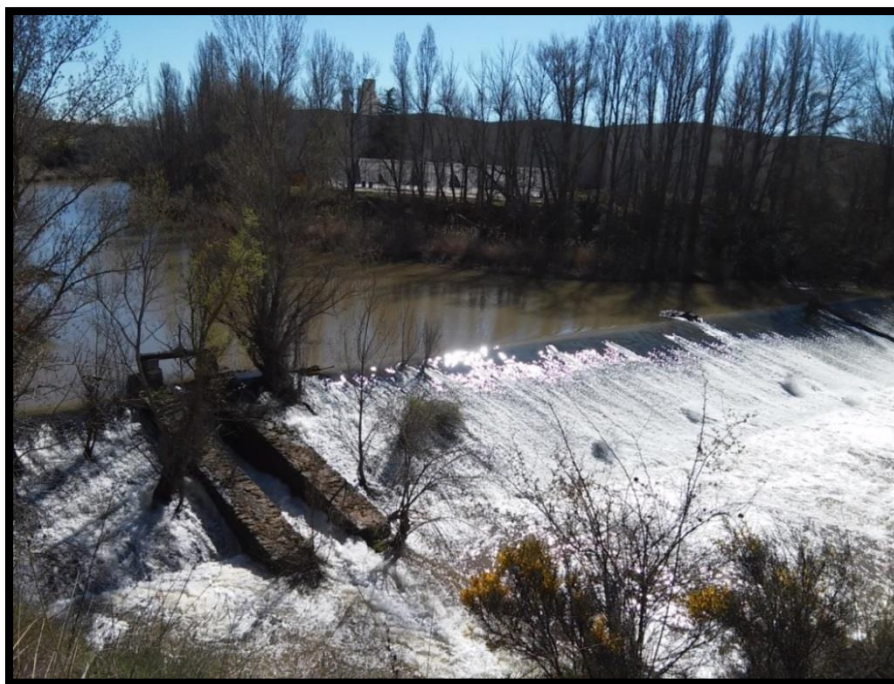
Presa de Fresno de las Dueñas (Burgos) en el río Duero, cuya demolición se realizó en el marco de la "Estrategia de mejora de la conectividad" en el año 2017. Autora: Verónica Orozco.
