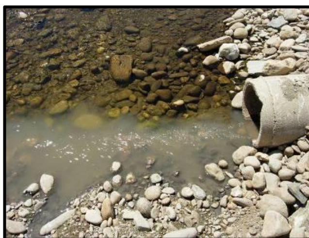
Vertido domestico sin depuración. Autor: Área de Calidad de las Aguas de la CHD.
