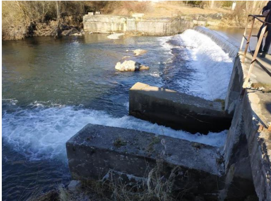
Figura 3 – Vista del azud de la antigua central hidroeléctrica en el municipio de Guardo, cuya demolición se contempla en el Proyecto.
