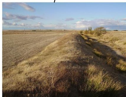
Mota. Defensa frente a inundaciones. Margen del río
