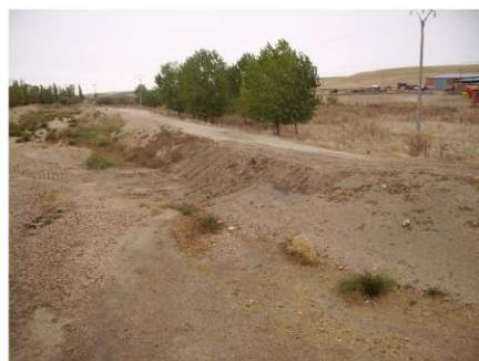
Relleno sin revestimiento. Defensa frente a inundaciones. Llanura de inundación
