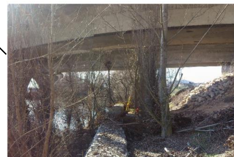
Gavión. Protección de márgenes. Margen del río
