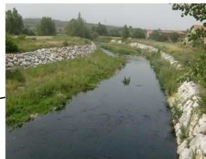
Escollera. Protección de márgenes. Margen del río
