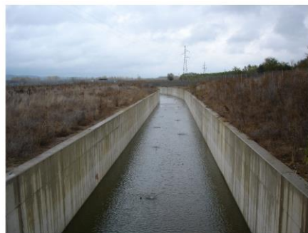
Muro. Protección de márgenes (canalización). Margen del río
