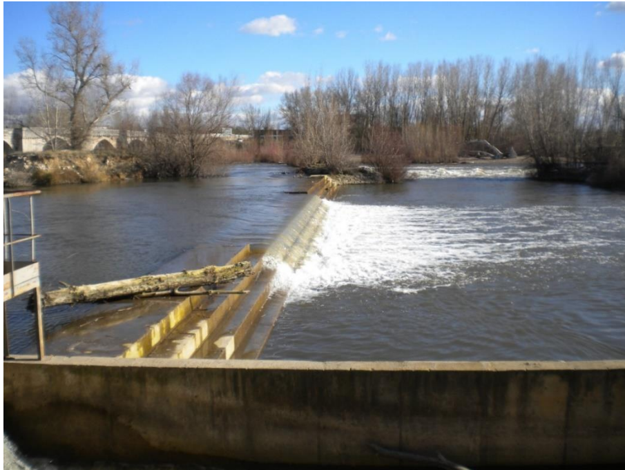
Figura 2 – Azud sobre el río Pisuerga, junto a una central hidroeléctrica abandonada en Simancas (Valladolid)
