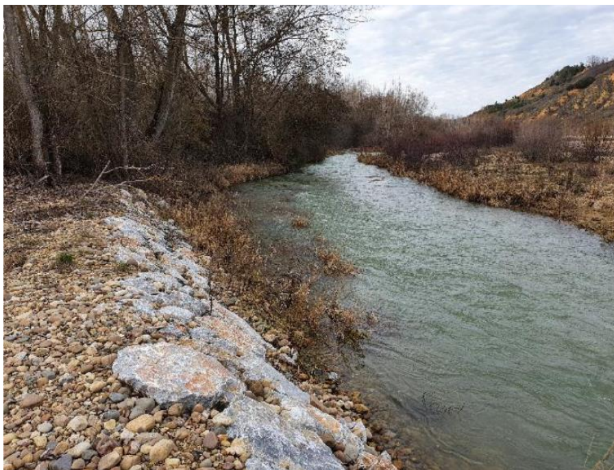
Figura 2 – Tramo del río Carrión protegido con escolera en su margen derecha, en el término municipal de Poza de la Vega
