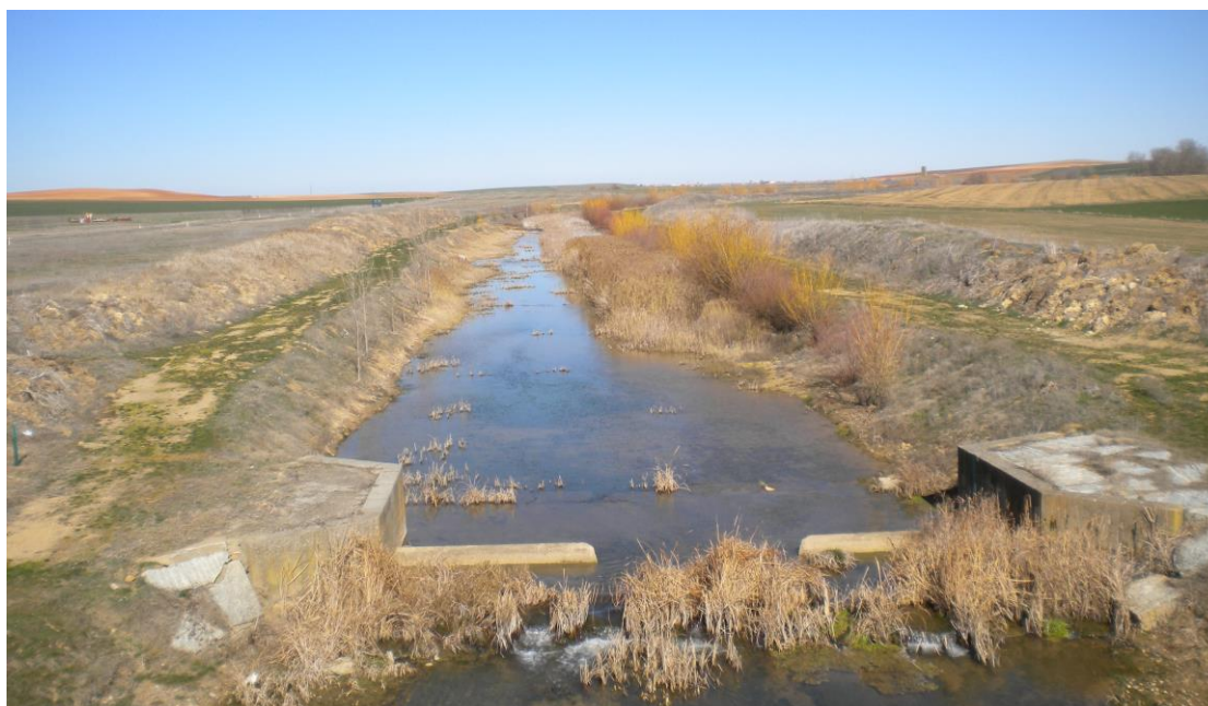
Figura 2 – Barreras longitudinales en ambas márgenes del río Valderaduey a la altura de la estación de aforos en Cañizo (Zamora)
