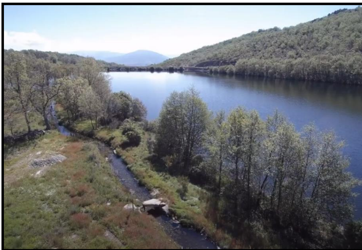
Dispositivo de paso para peces de tipo “río artificial” en la presa de Santa Lucía (Ávila). Fuente: CHD
