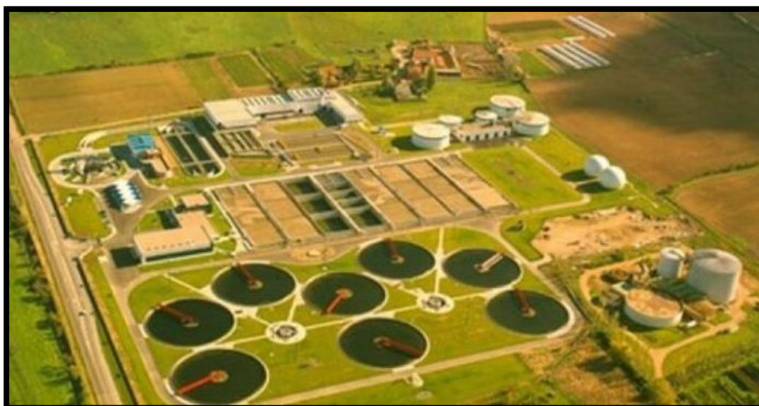
EDAR de la ciudad de Valladolid
