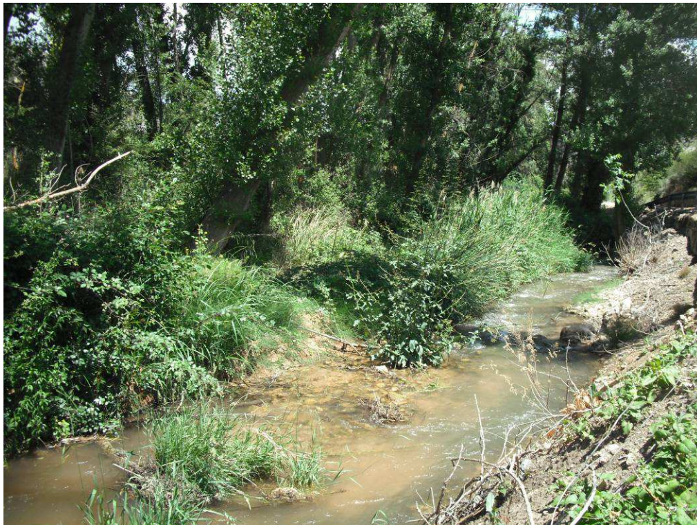
Figura 1. Cauce del río Escalote en la zona encañonada, se aprecia inestabilidad de la orilla izquierda por la presencia del talud de una carretera.
