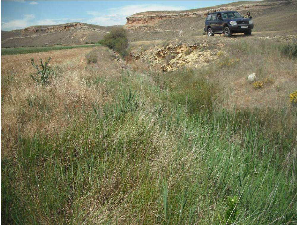
Figura 10. Canal lateral que parte de un azud en el río Escalote, en Caltojar, la presencia de esta infraestructura produce una disminución de la funcionalidad de la llanura de inundación.
