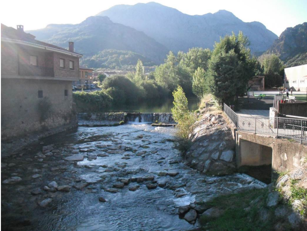
Figura 8. Río Torío. Localidad: Vegacervera. Azud de hormigón con código 4068. Es franqueable para algunos peces.
