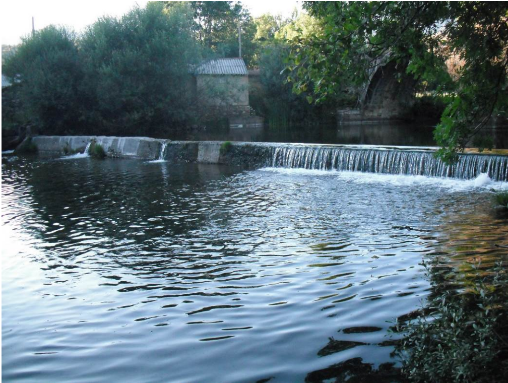
Figura 10. Río Torío. Localidad: Villalfeide. Azud de hormigón con código 4072. Es franqueable, y no tiene dispositivo de franqueo.
