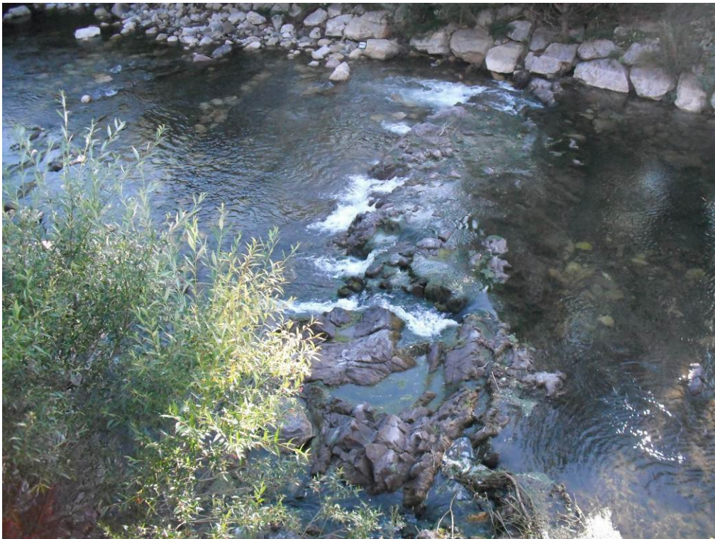
Figura 9. Río Torío. Localidad: Vegacervera. Azud de mampostería con código 4070. Es franqueable, no tiene dispositivo de franqueo.
