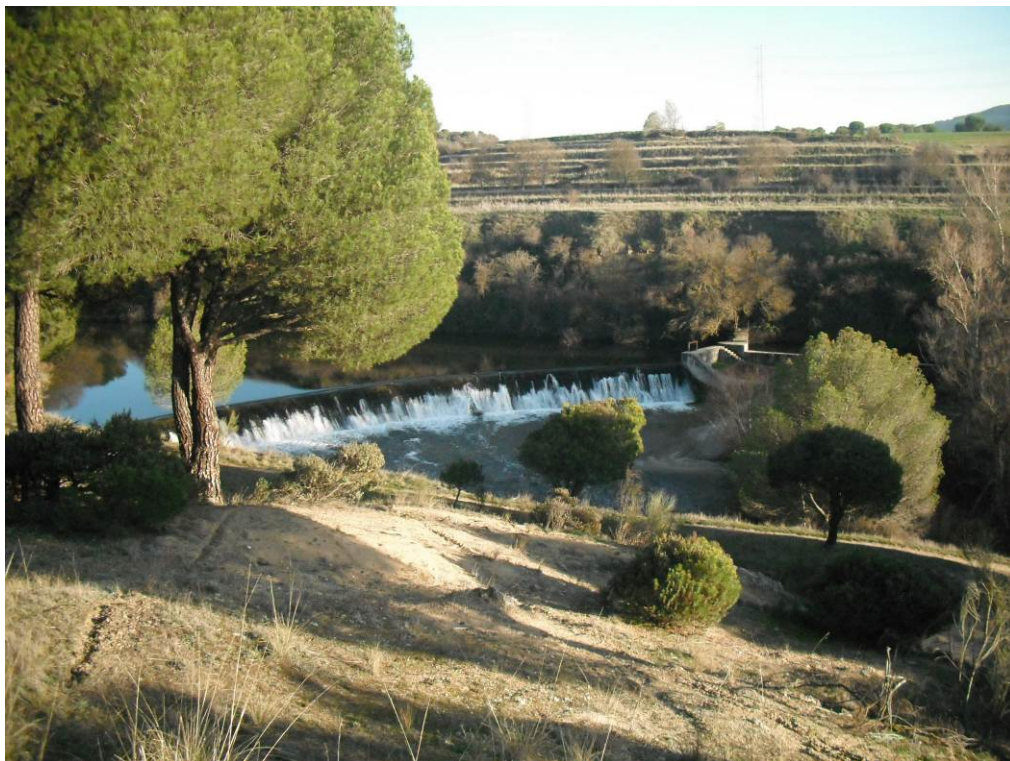
Figura 13. Azud con código 1624 en el río Eresma en Alcazarén esta obra pertenece a una central hidroeléctrica, es infranqueable aunque tiene una escala de peces en el lado derecho.
