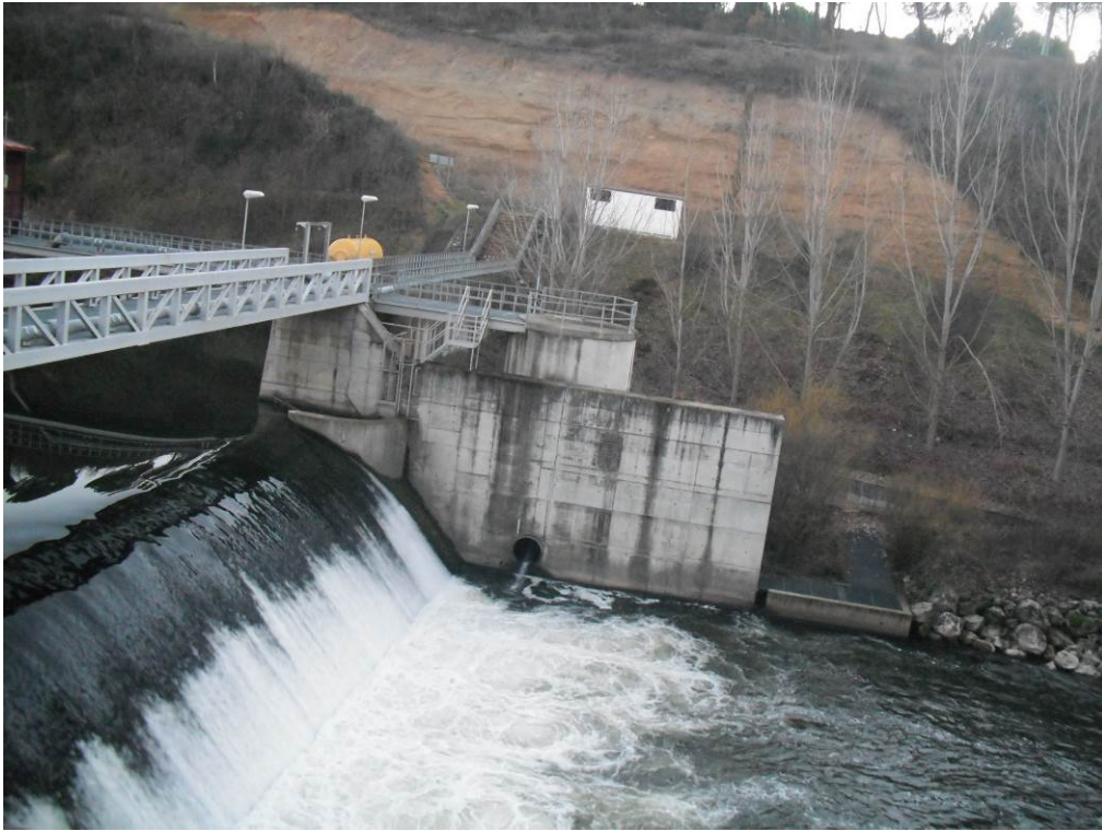
Figura 14. Gran presa con código 1617 en el río Eresma en Villeguillo, esta infraestructura acumula agua para una central hidroeléctrica, es infranqueable y supone una alteración grave para este río.
