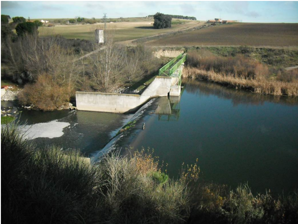
Figura 8. Azud con código 1620 para producción hidroeléctrica en Olmedo infranqueable.
