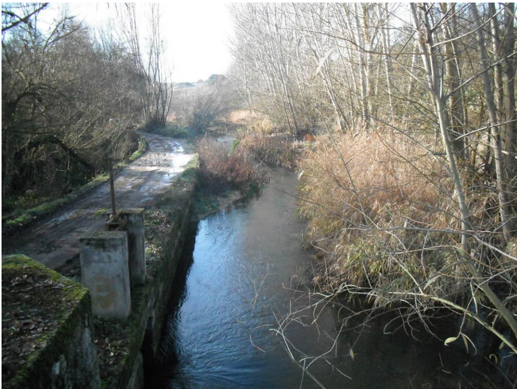
Figura 7. Azud con código 1694 en Donhierro que es aprovechado para el paso a una finca, está en uso de este parte un canal de riego, es infranqueable. La permeabilización de este
