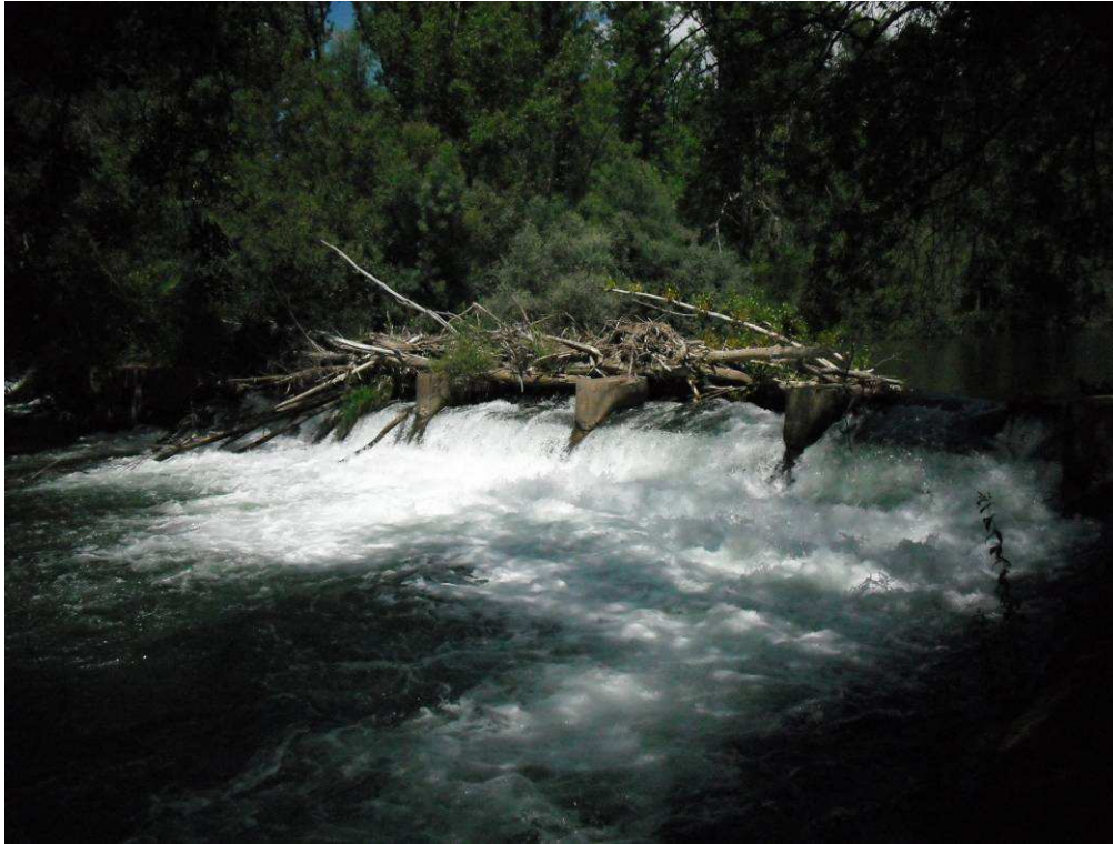
Figura 19. Río Esla, azud con código 3394 en Villahibiera. De franqueabilidad variable, dependiendo de la estación y el caudal.
