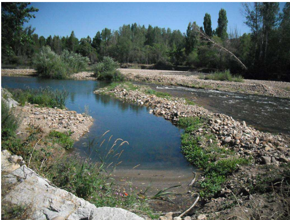
Figura 22. Río Bernesga en Lorenzana, la barra de piedras acumulada se utiliza para desviar agua a un canal próximo, una obra que acumula sedimentos y altera el régimen de los caudales, aunque como obstáculo es franqueable.
