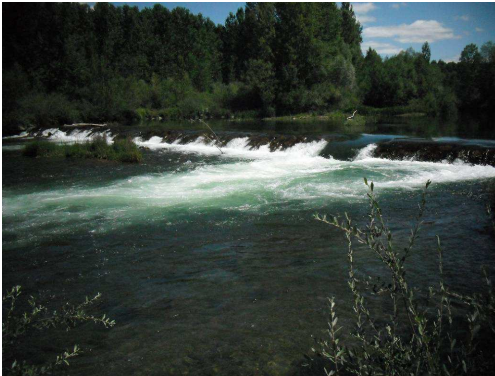
Figura 17. Azud con código 3397, en el río Esla en Villamor, de piedra no tiene dispositivo de franqueo.
