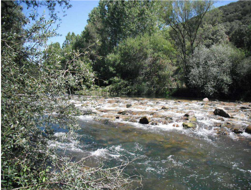
Figura 23. Río Bernesga en La Seca, azud con código 2283, construido con piedra, de poca altura es franqueable.
