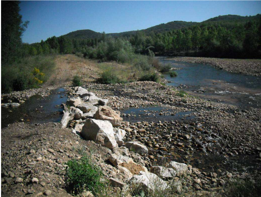
Figura 11. Tramo del río Bernesga, en Lorenzana, presencia de motas y escollera, que impide la conectividad lateral del cauce con la llanura de inundación.
