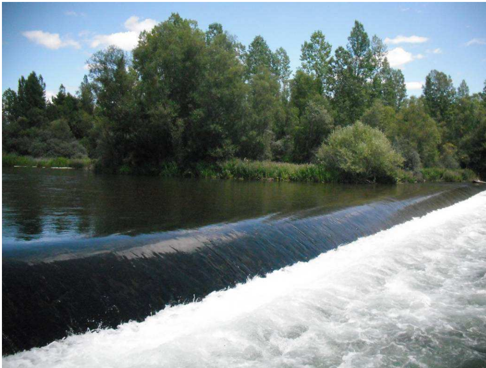
Figura 20. Río Esla, este azud con código 3396, de grandes proporciones tiene escala de peces, pero se encuentra en un tramo en el que varios azudes aguas arriba y aguas abajo no la tienen y hacen poco práctica en términos de longitud de río liberado, su efectividad.
