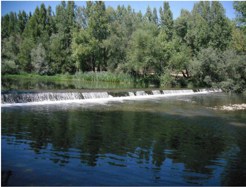
Figura 27. Río Bernesga en Santa Olaya de la ribera, azud con código 2295, le está construido en hormigón y es infranqueable.
