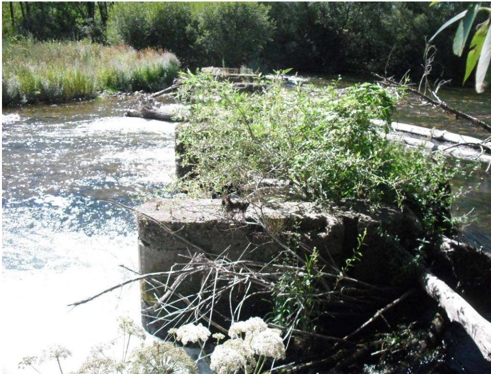
Figura 21. Río Esla en Vega de Monasterio, azud con código 3390. Es infranqueable y no tiene dispositivo de paso.
