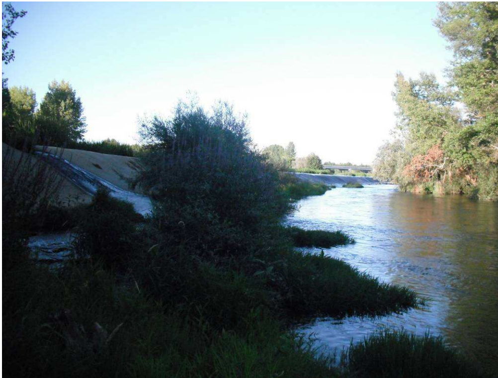
Figura 29. Río Esla en Britó, azud no calificado en forma de U, que no ocupa transversalmente todo el ancho del cauce, sirve para desviar una parte del caudal a un canal de riego, como deja una parte de río libre, es un obstáculo franqueable. Esta es una zona donde la presencia de obstáculos es muy baja y se podría liberar una gran parte de espacio fluvial con una intervención no muy costosa.
