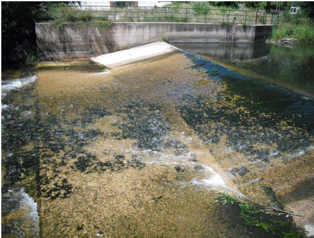
Figura 24. Río Bernesga en Cascantes, estación de aforo, con código 2303, la solera tienen más de 13 m. y lo convierte en un obstáculo infranqueable.
