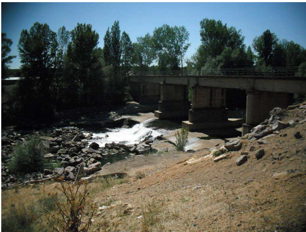
Figura 28. Río Bernesga en Alija de la Ribera, azud situado en un puente con código 2310, la solera tienen más de 10 m. y lo convierte en un obstáculo infranqueable.
