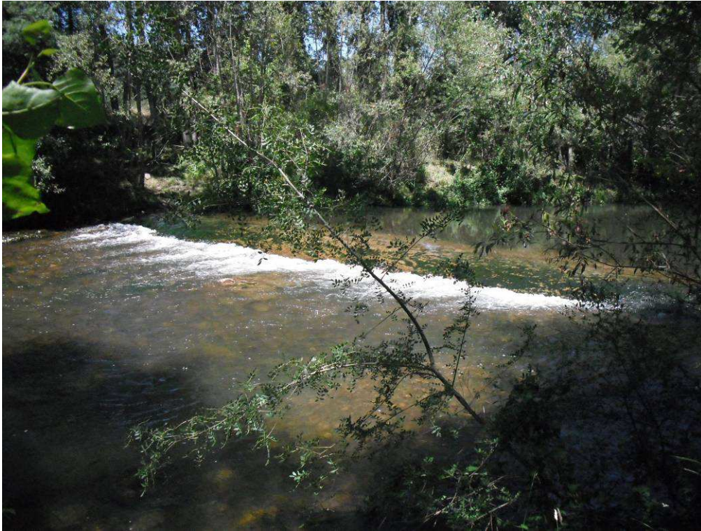
Figura 25. Río Bernesga en Cascantes, azud con código 2288, construido con piedra, de poca altura es franqueable dependiendo de la estación y el caudal.
