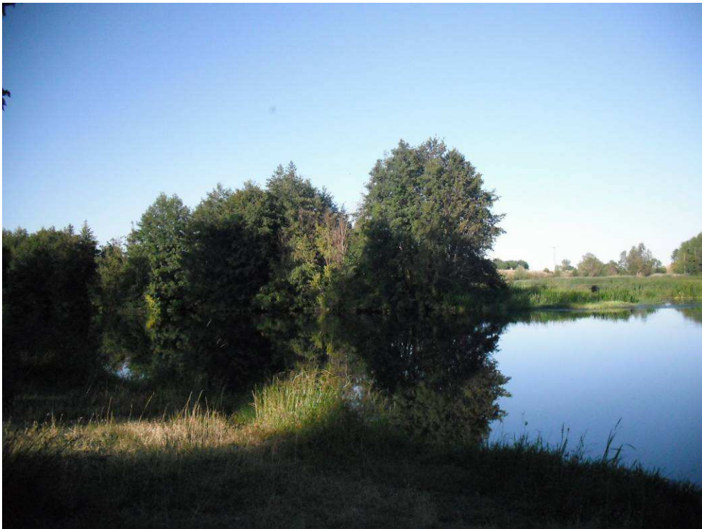
Figura 15. La presencia de los azudes provoca una modificación de la morfología del tramo, aparecen zonas donde la acumulación de sedimentos provoca la proliferación de macrófitos, y en ocasiones las orillas inestables hacen muy difícil la colonización de estos tramos por vegetación leñosa de ribera.
