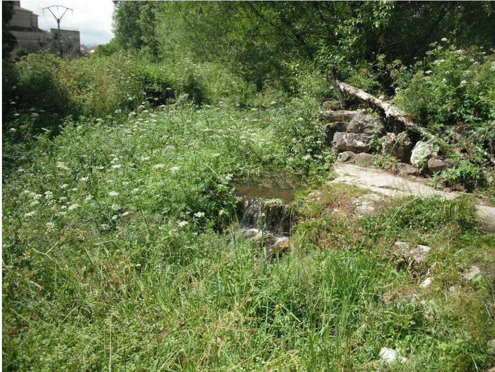
Figura 6. Azud con código 1503 en el río San Juan, sin uso, no tiene dispositivo de franqueo.
