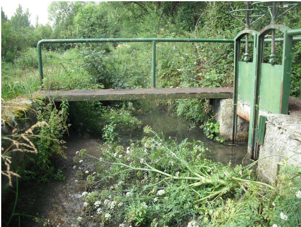
Figura 5. Azud con código 1504 en el río San Juan, en Prádenas, actualmente en uso, es infranqueable.
