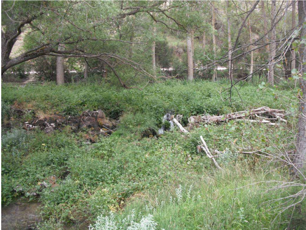
Figura 8. Azud en el río Avión en las proximidades de la Fuentona, que se utilizaba para abastecer a instalaciones situadas aguas abajo y que ahora está en desuso.
