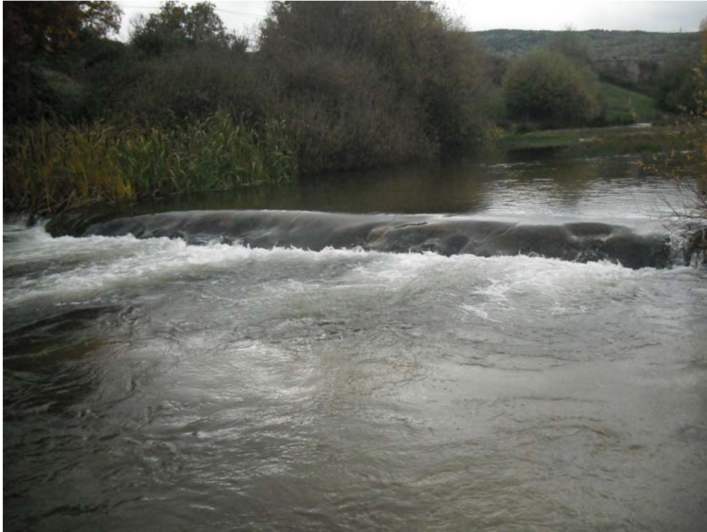
Figura 12. Azud con código 1396 en Valsaín, se usa para crear una zona de recreo aguas arriba. Es de piedra y franqueable.
