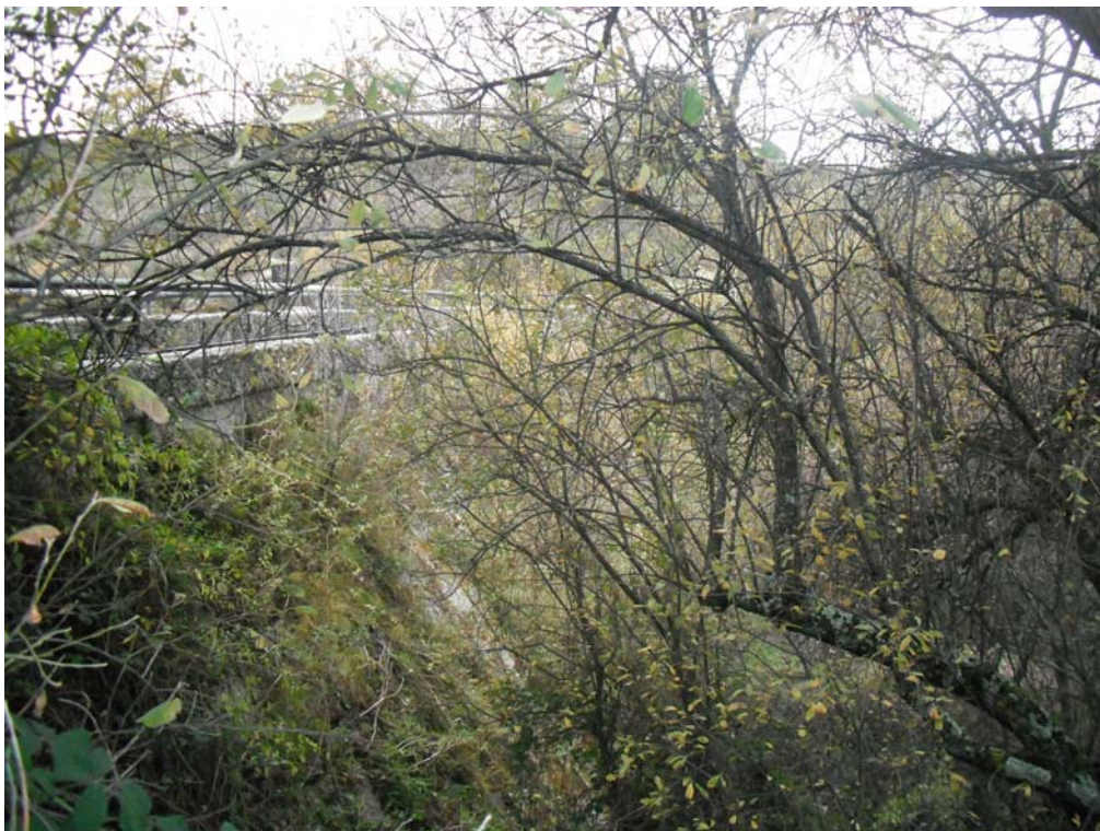
Figura 15. Presa del Eresma en Valsaín con código 1399. Es una presa de grandes dimensiones construida en hormigón e infranqueable.
