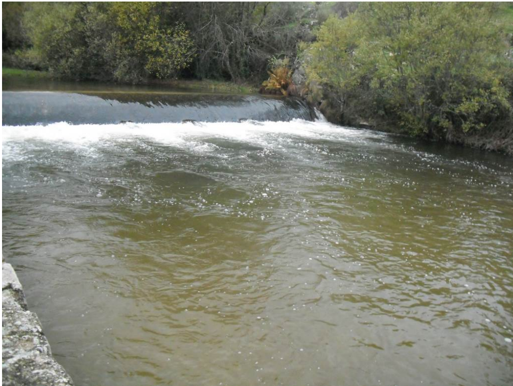
Figura 10. Azud con código 1385, en el río Eresma, que forma parte de un sistema de dos azudes con una solera sólida en el centro que lo hacen infranqueable.
