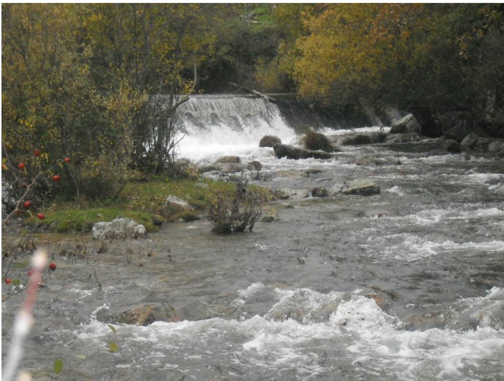
Figura 11. Este azud está a continuación del de la imagen anterior, tiene 2,5 m de alto y forman en su conjunto un obstáculo infranqueable para la fauna.
