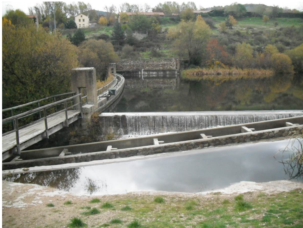
Figura 13. Gran presa en el Eresma con código 1399, tienen un canal lateral funcional y cuenta con una gran escala de peces, para salvar los 20 m. de altura del obstáculo.
