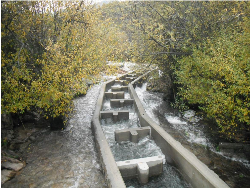
Figura 14. Escala de peces que discurre por el canal para hacer permeable el obstáculo denominado Presa del olvido, de gran tamaño en la localidad de Valsaín.
