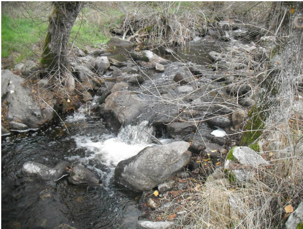
Figura 17. Río Vadillos, azud con código 1516 en Pedraza, de piedra está muy deteriorado y, formaba parte de un sistema de abastecimiento a unos batanes. Es el único obstáculo de este río.
