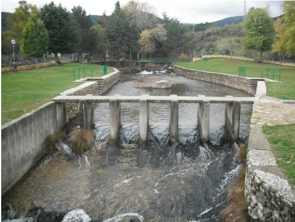
Figura 16. Sistema de azudes con códigos 1521 y 1522, en una zona de recreo del río Cega en Navafrias. La solera de gran tamaño de este primer azud hace el obstáculo infranqueable.
